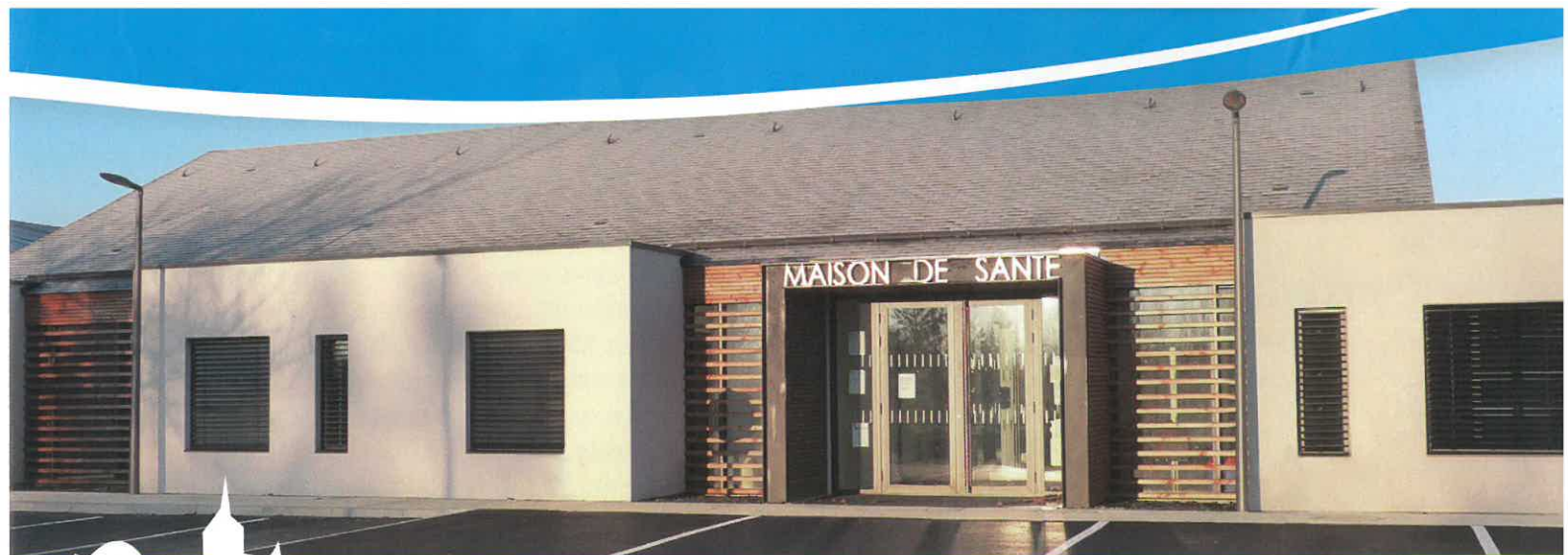
Maison de Santé de Varennes-sur-Loire
